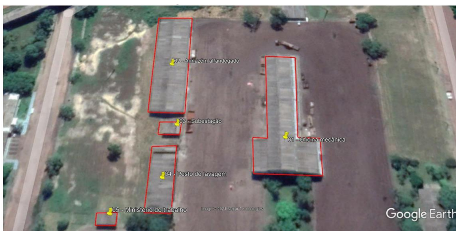
Figura 1 – Estruturas existentes no VDC04 Fonte: CDP
